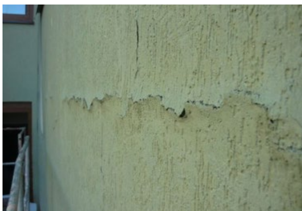
Příčiny vzniku trhlin
