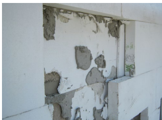
Sanace chybného lepení a vrstvení ETICS
