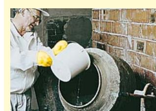
Do míchačky se nejdříve nadávkuje čistá voda cca 4 l na jeden pytel (25 kg) a za stálého míchání se vysypává suchá směs. Hmota se míchá cca 5 minut. Případné dodatečné přidání vody provádíme pomalu a opatrně tak, aby hmota na konci míchacího cyklu byla požadované konzistence.
