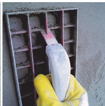
Obr.4 Následující den strhnout povrch škrabákem.
