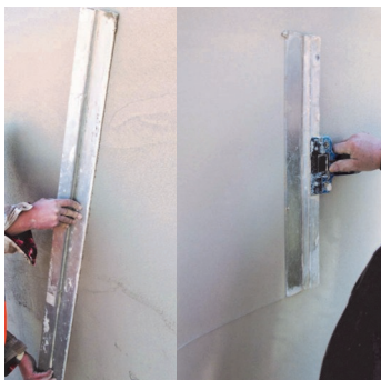
Obr.2 Urovnání povrchu "h-latí" a fasádní špachtlí.
