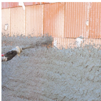
Obr.1 Nástřik omítky pomocí omítačky.
