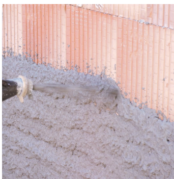
Obr.2 Nástřik omítky pomocí omítačky nebo ze síla.
