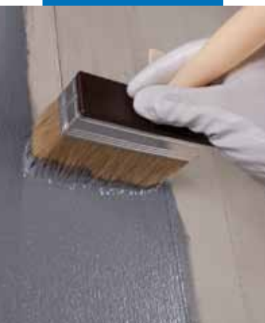
Nanášení Eco Primu Grip štětkou na betonový podklad
