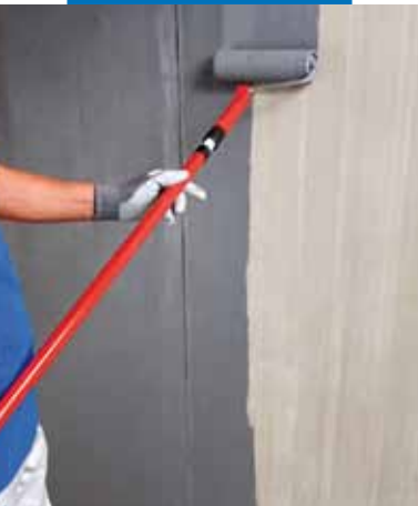
Nanášení Eco Primu Grip válečkem na betonový podklad
