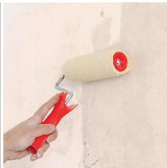
Obr.3 Provedení penetračního nátěru.
