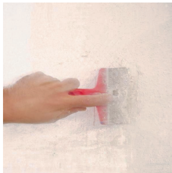
Obr.2 Odstranění nesoudržných vrstev.
