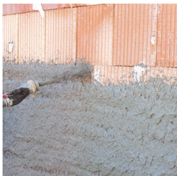
Obr.1 Nástřik omítky pomocí omítačky.
