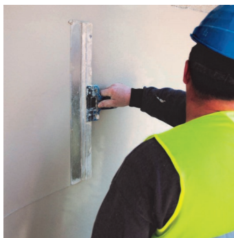
Obr.3 Urovnání povrchu fasádní špachtlí.
