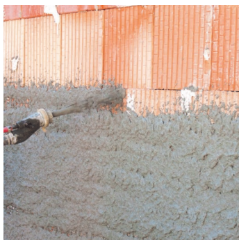
Obr.1 Nástřik omítky pomocí omítačky.
