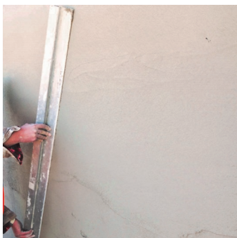
Obr.2 Urovnání povrchu "h-latí".
