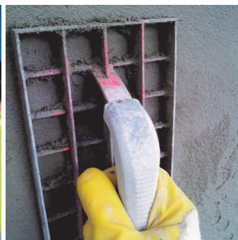
Obr.4 Následující den strhnout povrch škrabákem.
