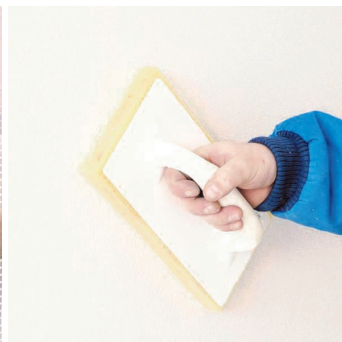
Obr.3b Filcování povrchu.
