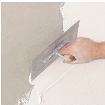
Obr.2 Nanášení pomocí hladítka, nebo nástřikem z omítačky.
