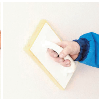
Obr.3b Filcování povrchu.
