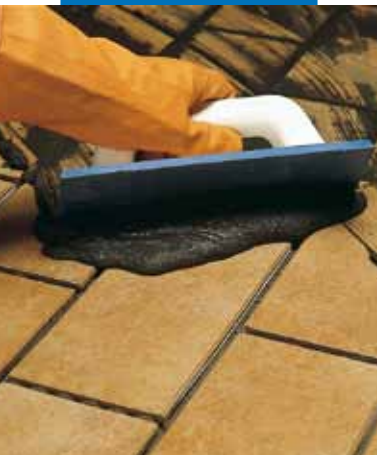
Spárování dlažby klinker Keracorem GG smíchaným s Fugolasticem
