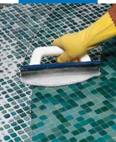
Spárování skleněné mozaiky Keracorem FF smíchaným s Fugolasticem
