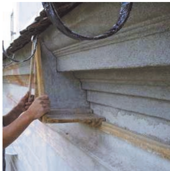
Obr.3 Tažení jemné malty maxit Feinzug ve tvaru profilu načisto.
