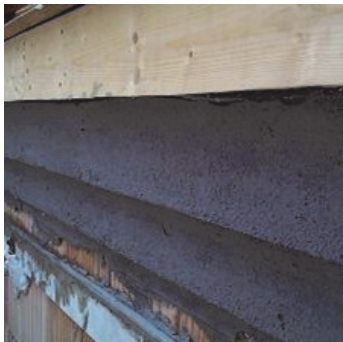
Obr.2 Tažení hrubé malty maxit Grobzug ve tvaru profilu nahrubo.
