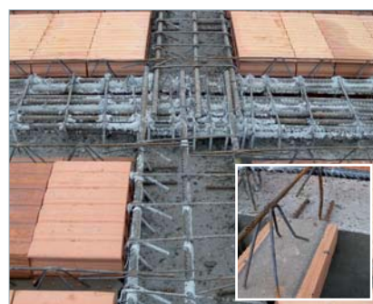
uložení trámečků do železobetonového průvlaku
