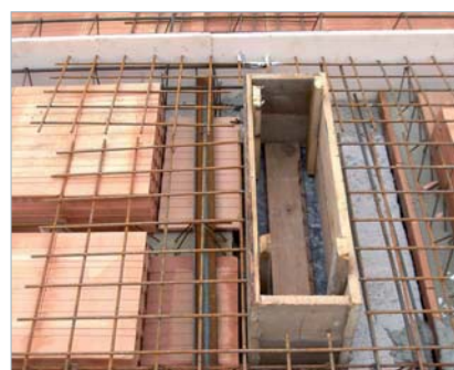
výměna u prostupu stropem pomocí vloženého úhelníku 75/50/6
