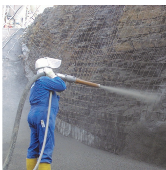
Obr.3 Nástřik betonu na podklad.
