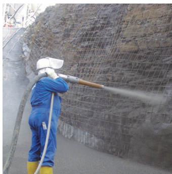
Obr.3 Nástřik betonu na podklad.
