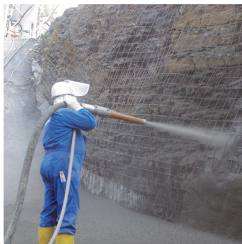
Obr.3 Nástřik betonu na podklad.
