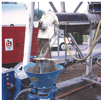
Obr.2 Dávkování suché směsi do podávacího stroje pomocí kontinuální míchačky namontované pod sílem.
