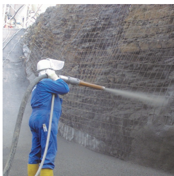
Obr.3 Nástřik betonu na podklad.
