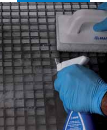
Nástřik výrobku Kerapoxy Cleaner na čistěný povrch
