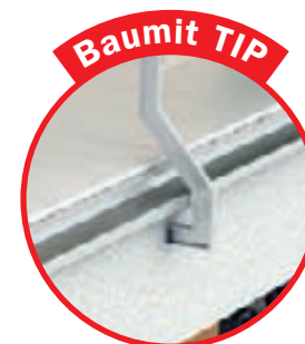
Zábradlí kotvěte z čela nebo spodního líce konstrukce.
