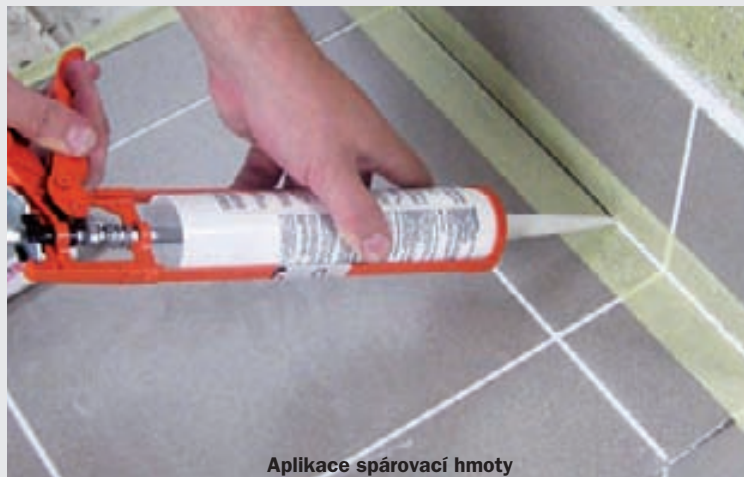
Aplikace spárovací hmoty
