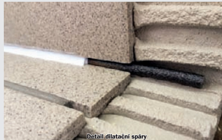
Detail dilatační spáry
