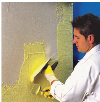
Obr.3 Nanesení omítky nerezovým hladítkem.
