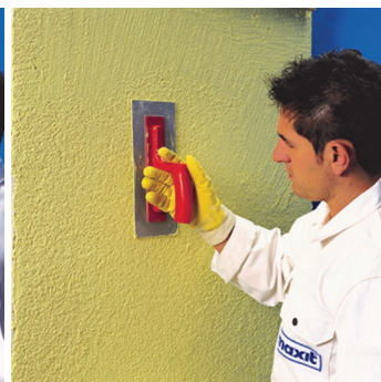
Obr.4 Strukturování povrchu plastovým hladítkem.
