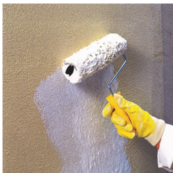
Obr.1 Podklad připravit předepsaným způsobem.
