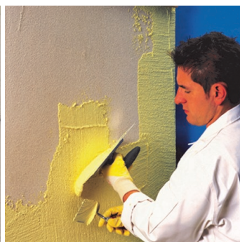
Obr.3 Nanesení omítky nerezovým hladítkem.
