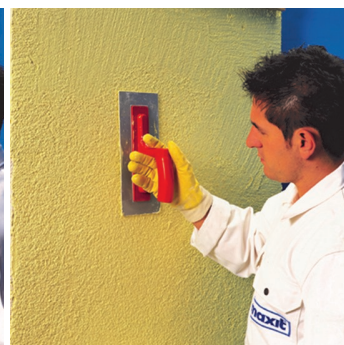
Obr.4 Strukturování povrchu plastovým hladítkem.
