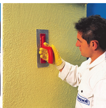
Obr.4 Strukturování povrchu plastovým hladítkem.
