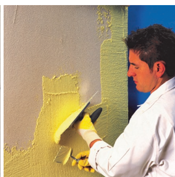
Obr.3 Nanesení omítky nerezovým hladítkem.
