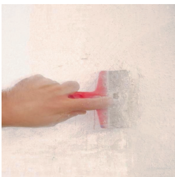
Obr.2 Odstranění nesoudržných vrstev.
