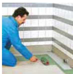
Nanášení tekuté hydroizolační folie
