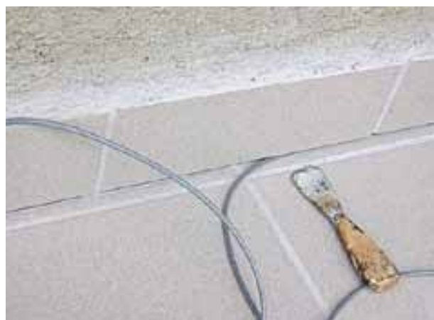
Zapravení separáčního provazce do spáry
