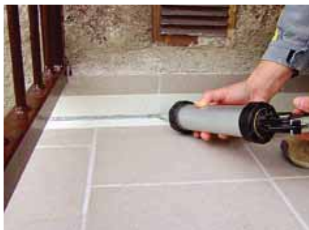
Zatmelení spáry PUR tmelem
