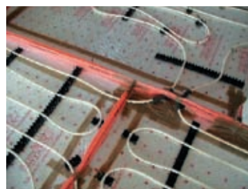
Prostup podlahového vytápění spárou
