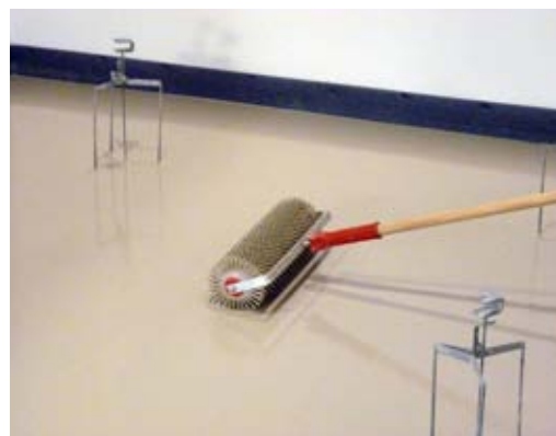
Vibrační lať a ježatý odvzdušňovací válec
