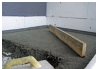
Realizace cementového potěru
