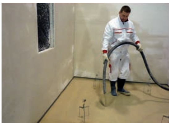
Lití potěru bez podlahového vytápění
