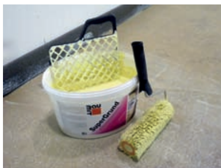
Nanesení základního nátěru Baumit SuperGrund vč. osazení okrajových dilatací
