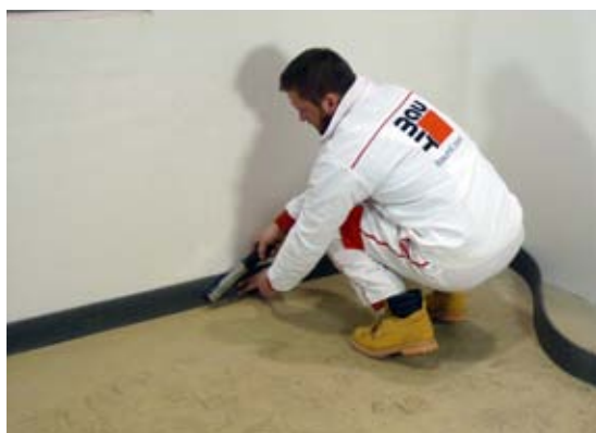
Montáž okrajové dilatační pásy, pokládání tepelně izolačních desek
