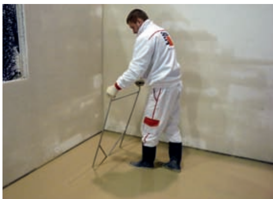
Vibrační lať a ježatý odvzdušňovací válec
