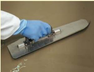
Namíchanou hmotu rovnoměrně naléváme na připravený podklad z míchacích nádob (při ručním zpracování) nebo hadicí s koncovkou (při strojním zpracování). Na hmotu upravíme nerezovou podlahářskou šavlí nebo raklí tak, aby byla celistvě rozprostřena na podkladu v příslušné tloušťce. V případě potřeby hmotu bezprostředně po srovnání odvzdušníme trnovým válečkem.
