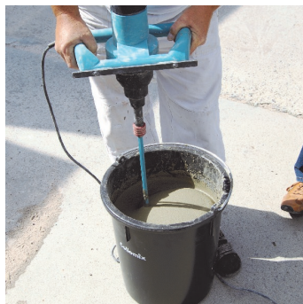
Obr.3 Namíchání materiálu pomocí míchadla nebo m-tec duo-mixu nebo za síla pomocí m-tec SMP PU.
