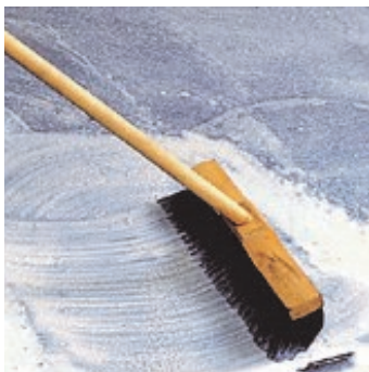
Obr.2 Podklad zpenetrovat předepsanou penetrací.
