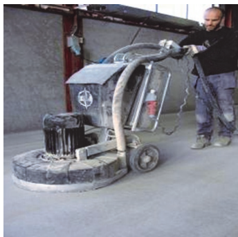
Obr.1 Podklad připravit předepsaným způsobem.
