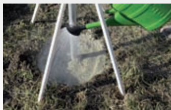
Zalítí směsi předepsaným množstvím vody, tloušťka jedné vrstvy max. 10 cm
