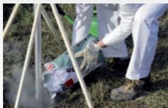
Vsypání suché směsi na předem připravené a navlhčené místo
