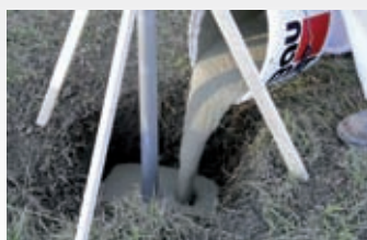
Aplikace směsi na předem připravené a navlhčené místo
