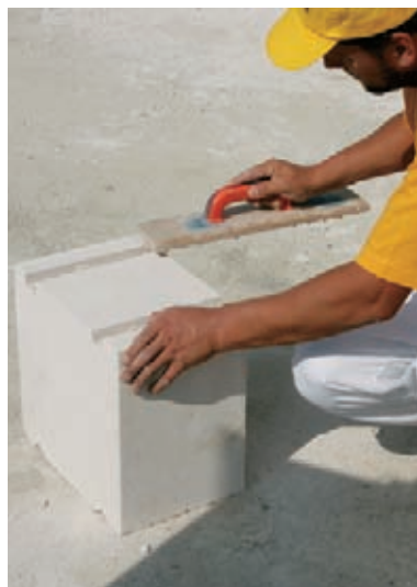
Kdo upřednostňuje přesnost, může vyřezat chybějící drážky i na odřezku tvárnice.
