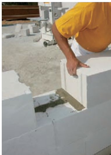
Doplňkový kus umístíme do střední části budoucího otvoru.
