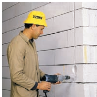
Otvory pro krabice vypínačů se jednoduše navrtají pomocí speciálního vrtáku. Vrtáčkou bez přiklepu a obyčejným vrtákem na železo vyvrtáme libovolný otvor.
