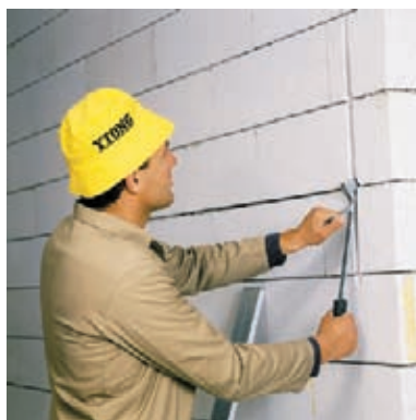
Vytváření drážek pomocí drážkovače představuje jednoduchý úkon.
