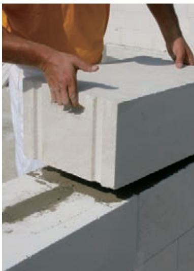
Tvárnice klademe do tenkovrstvé zdicí malty.
