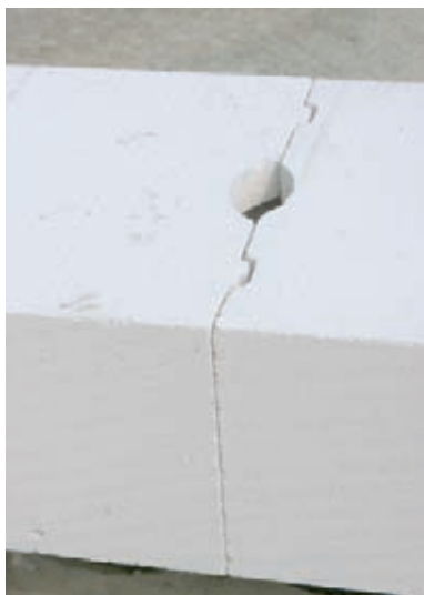
Detail suchého styku pero – drážka.
