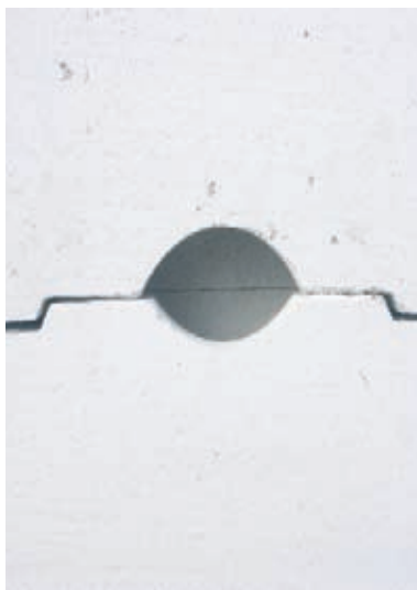
Profilování per a drážek zajistí těsnost styku i bez malty.
