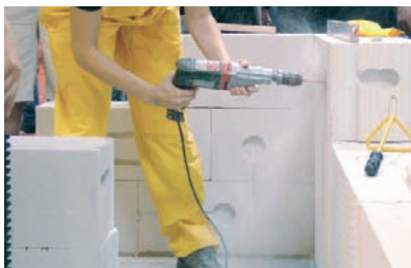
Vrtání do pórobetonu je jednoduché.
