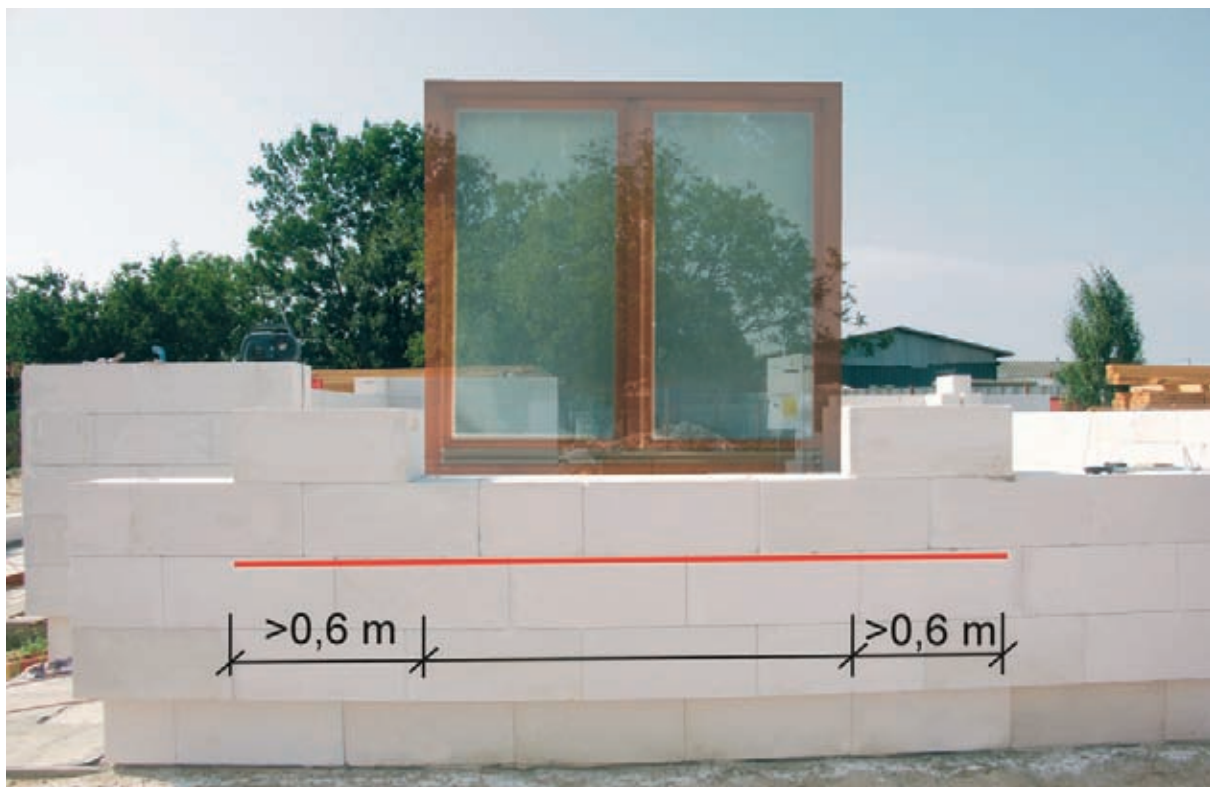
Vyměříme šířku budoucího otvoru a osadíme krajní tvárnice. Budoucí parapet má hrubou výšku 1 000 mm (4 řady tvárnic).
