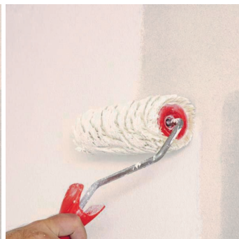
Obr.4 Nanášení následných nátěrů maxit prim 1110 maxit Siliconharzfarbe AS
