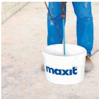
Obr.2 Promíchání penetračního nátěru.
