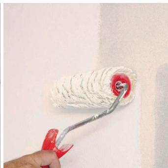
Obr.3 Nanášení biocidní penetrace maxit prim 1120
