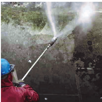
Obr.1 Očištění podkladu tlakovou vodou.
