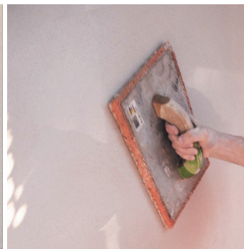
Obr.4 Vyhlazení povrchu houbovým nebo filcovým hladítkem.
