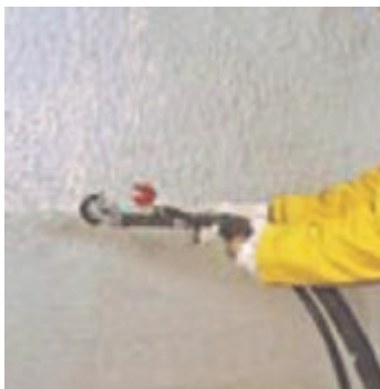
Obr.2 Nástřik omítky pomocí omítačky nebo ze síla.
