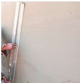
Obr.3 Urovnání povrchu.
