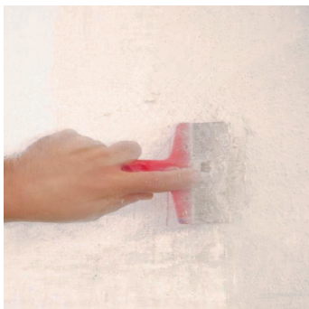
Obr.2 Odstranění nesoudržných vrstev.
