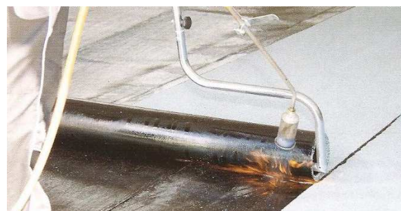
Variantní natavování s rozbalovačem rolí
