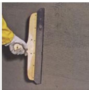
Obr.3 Odvzdušnění omítky rakletovou špachtlí.
