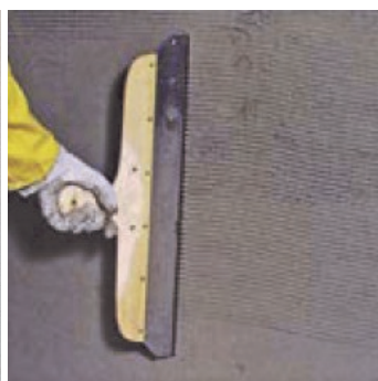
Obr.3 Odvzdušnění omítky rakletovou špachtlí.
