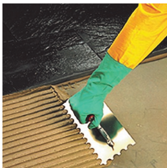
Obr.3 Nanášení lepidla na podklad.
