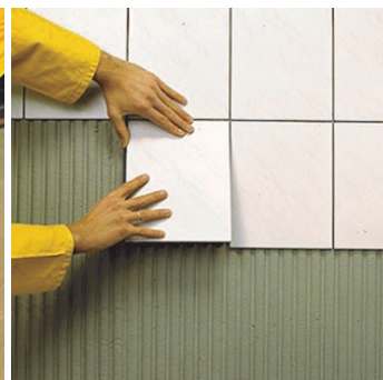
Obr.3 Lepení obkladů nebo dlažby.
