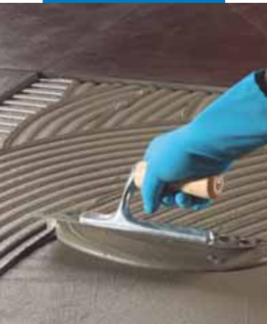
Nanášení Keraflexu Easy na podklad pomocí stěrky se zaoblenými zuby
