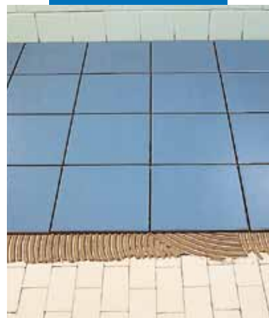
Lepení dlažby na stávající dlažbu šedým Keraflexem
