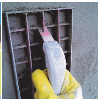
Obr.4 Následující den strhnout povrch škrábákem.
