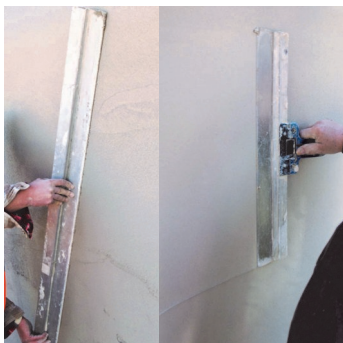
Obr.2 Urovnání povrchu "h-latí" a fasádní špachtlí.
