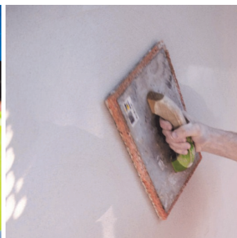
Obr.4 Následující den přetáhnout v tloušťce zrna stejným materiálem a uhladit houbovým hladítkem.
