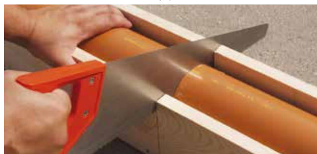
Obrázek 2 Zkracování trubky pilkou
