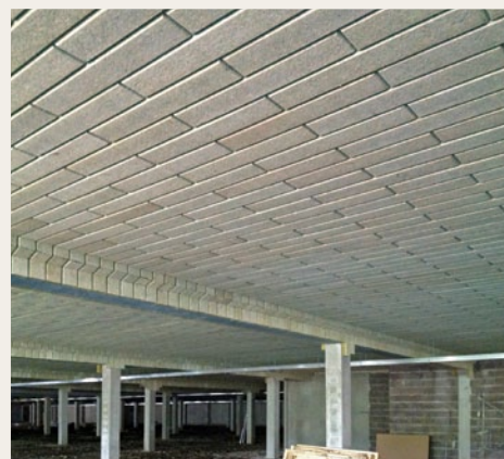
Příklad aplikace izolace Fasrock LG1 v praxi
