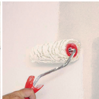
Obr.4 Provedení penetračního nátěru v 1 nebo více vrstvách.
