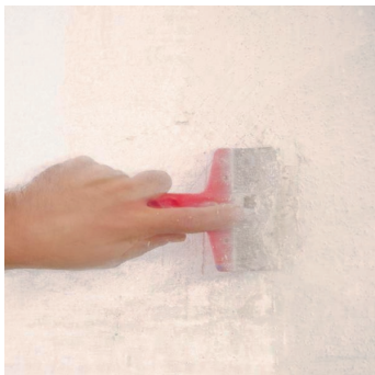
Obr.2 Odstranění nesoudržných vrstev.
