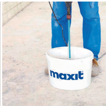
Obr.3 Promíchání penetračního nátěru.
