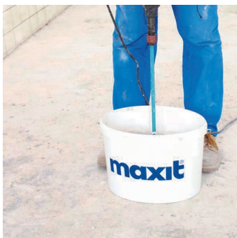
Obr.2 Namíchání lepidla míchadlem.
