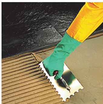
Obr.3 Nanášení lepidla na podklad.
