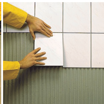
Obr.3 Lepení obkladů nebo dlažby.
