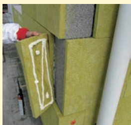
Příklad řešení detailu vazby rohu budovy pomocí dodatečně lepené uzavírací desky Isover TF PROFÍ tloušťky 30mm.
