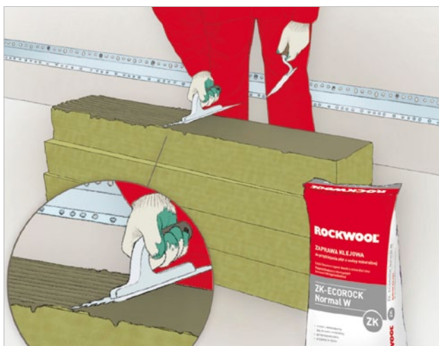
Nanášení lepicí hmoty na celý povrch.
