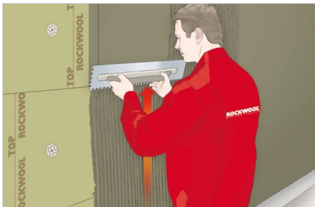
Nanesení krycí stěrkové hmoty zubatým hladítkem.
