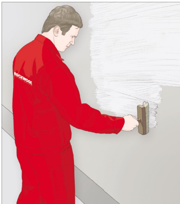
Natírání podkladu penetrací před aplikací vlastní fasádní barvy.
