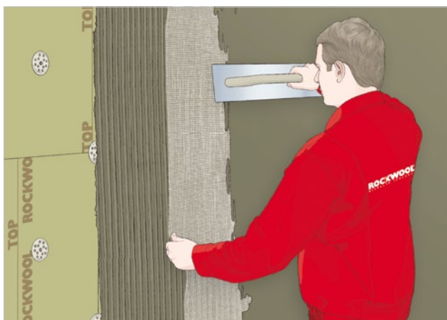
Vložení sítě ze skelného vlákna a vyhlazení povrchu. Je zakázáno aplikovat stěrkovou hmotu tzv. "protlačováním" skrz výztuž.
