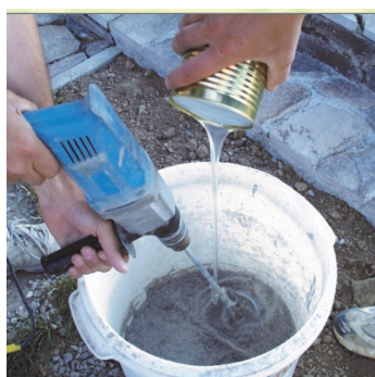
Obr.2 Smíchání obou složek ve větší nádobě pomocí míchadla.
