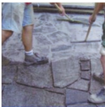
Obr.3 Zatlačení a upěchování spárovací hmoty do spár gumovou stěrkou.
