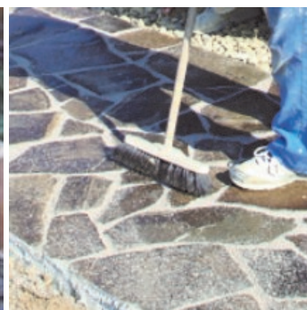
Obr.4 Smetení zbytků spárovací hmoty měkkým koštětem.
