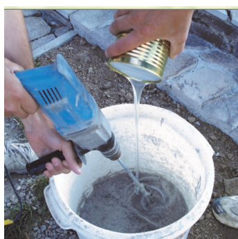
Obr.2 Smíchání obou složek ve větší nádobě pomocí míchadla. Případně lze zředit do 10% vodou.
