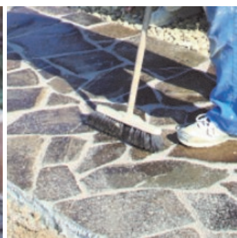
Obr.4 Smetení zbytků spárovací hmoty měkkým koštětem.
